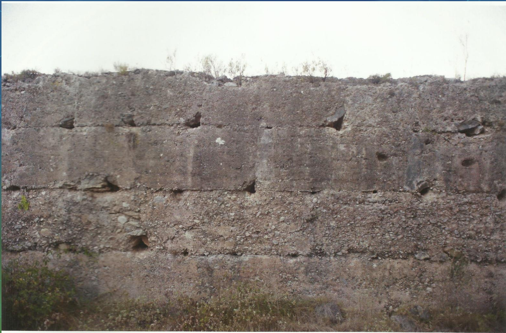
Tapial del mur interior, Castell del Xio
