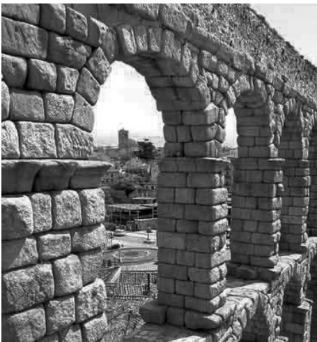
L'aqüeducte de Segòvia està construït amb 20 400 blocs de granit.
