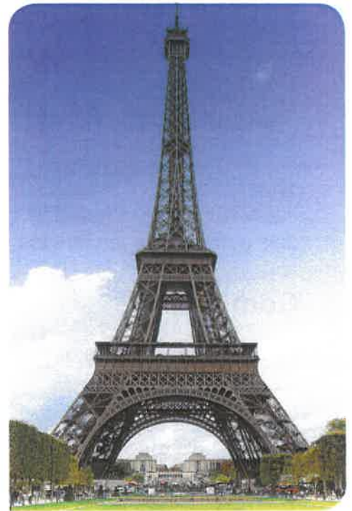
2 La torre Eiffel, construïda a París en 1889.
