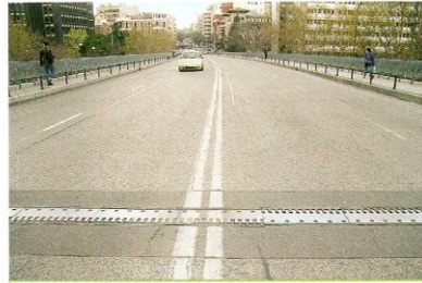
❶ Junta de dilatació en un pont. La junta de dilatació permet que el pont es dilate sense que se'n deteriore el ferm.
