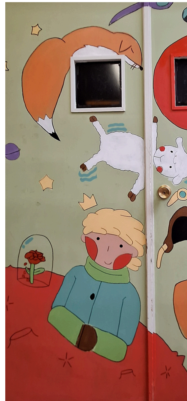
Actuació en les portes de les aules del col·legi Antonio Machado de Torrent. Abril de 2025.
