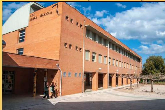
Façana i ala lateral de l'edifici.
