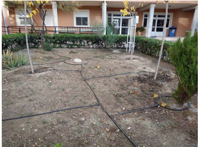
Instalación riego y piquetas (imagen superior izquierda)
