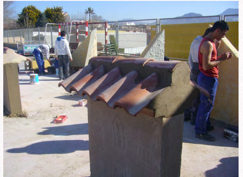
Aleros de una cubierta
