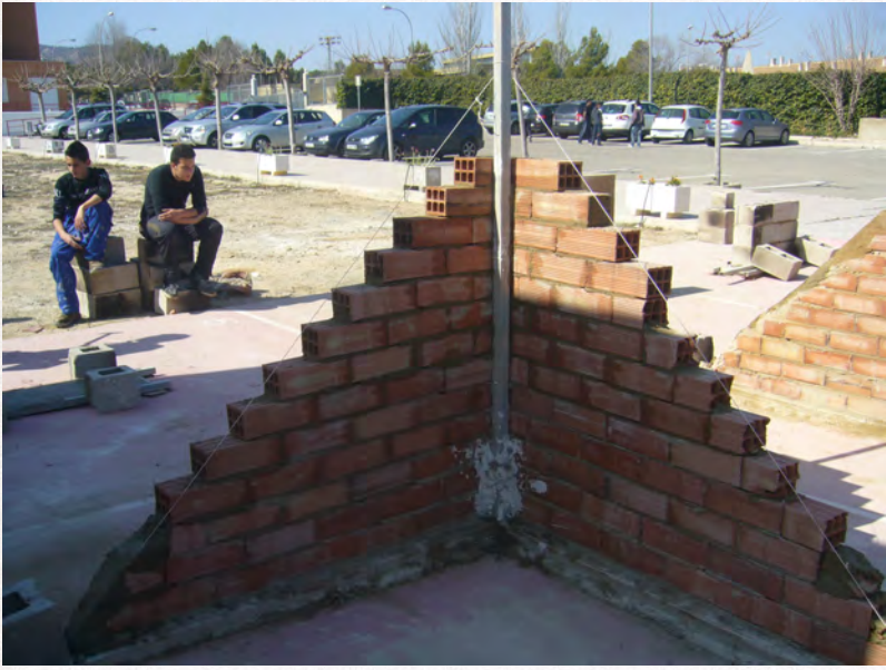
Arranque de un muro
