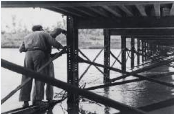
Construcció d'un pont dissenyat per Ovidio Botella Pastor sobre el riu Ebre (1938)
