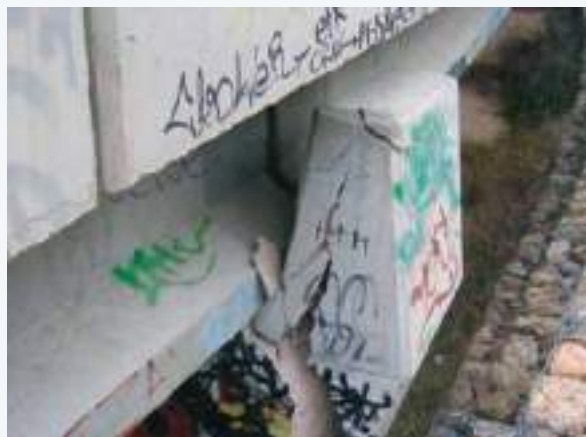
Desplaçament del pont d'accés al Polígon Santiago Payá
