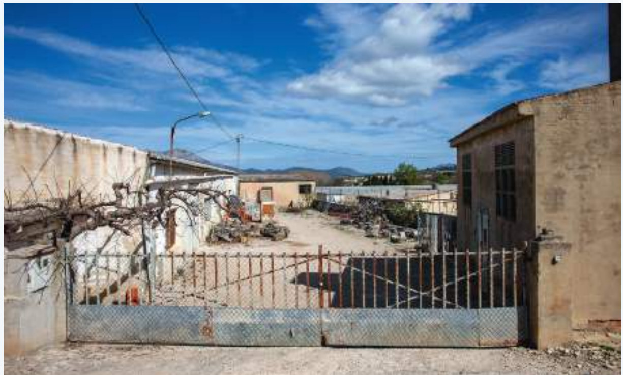
Estat actual de les instal·lacions d'Ardystil
