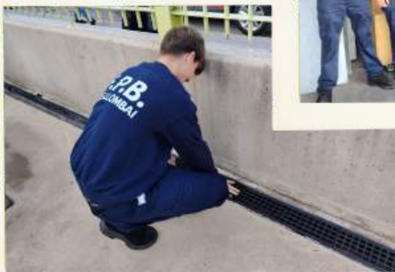
LIMPIEZA Y SUSTITUCIÓN DE REJILLAS
