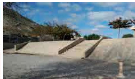
2012. Arreglo del desnivel del terreno y recubrimiento de piedra.
