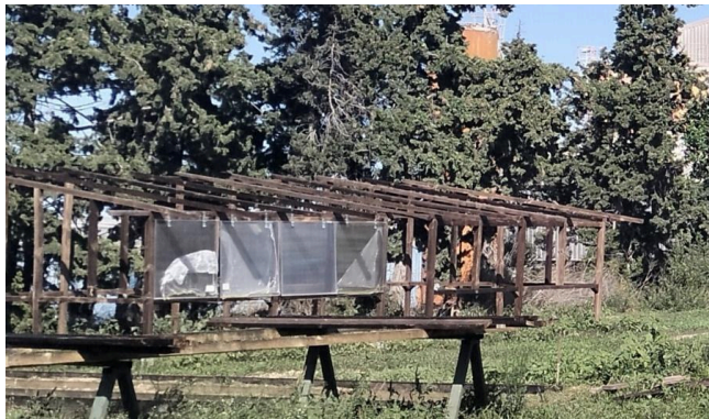
(Figura 18) El invernadero en construcción. Fuente: Propia
