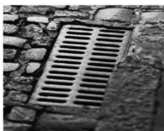
Les tapadores de clavegueres solen ser de ferro colat.
