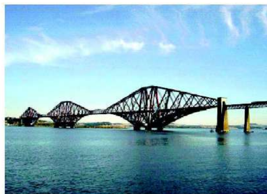
Pont mènsula, Pont ferroviari, Forth.
