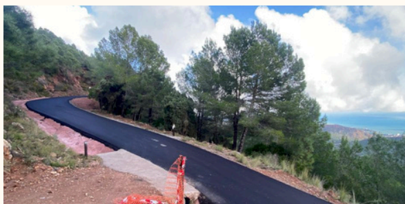
Nuevo tramo asfaltado del Destert de Les Palmes.
