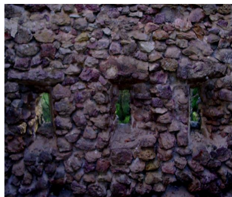
Aspilleras en la parte inferior
