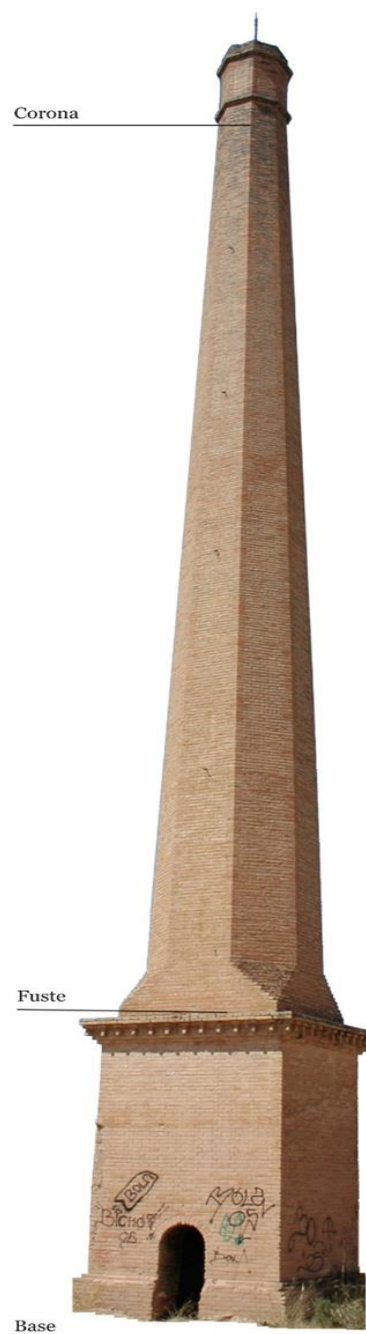
Partes de una chimenea
