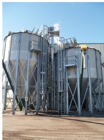
Imagen: Silos almacenamiento
