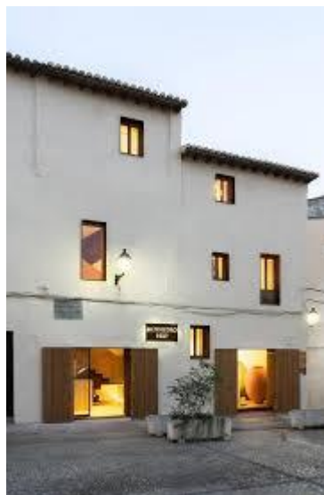
Imagen de la fachada
