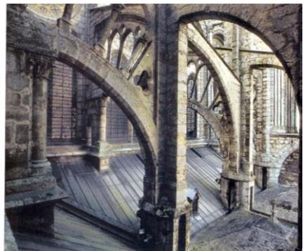
e) **Pináculo**. Es un remate saliente, a menudo decorado con labores de fronda, flores, etc. Posee, además, la misión de ejercer, con su propio peso, un empuje vertical sobre el contrafuerte que contrarreste el oblicuo que sobre el mismo ejercen los arbotantes, evitando con ello su desplazamiento.
