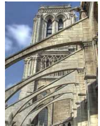
Arbotantes o arcos exteriores que separaban los contrafuertes del muro y lo aligeraban..
