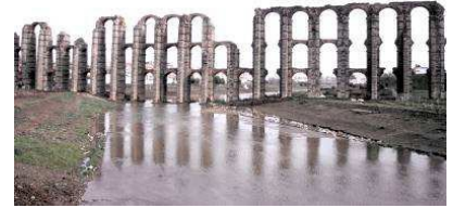
Acueducto de los Milagros , de granito y ladrillo para llevar agua al lado oeste de Emérita Augusta.
