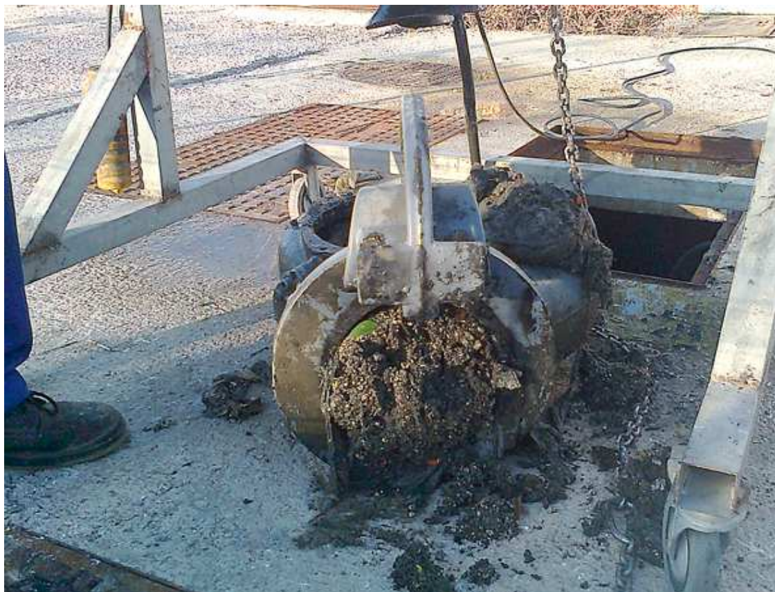
Tramos de tubería colapsado por toallitas
