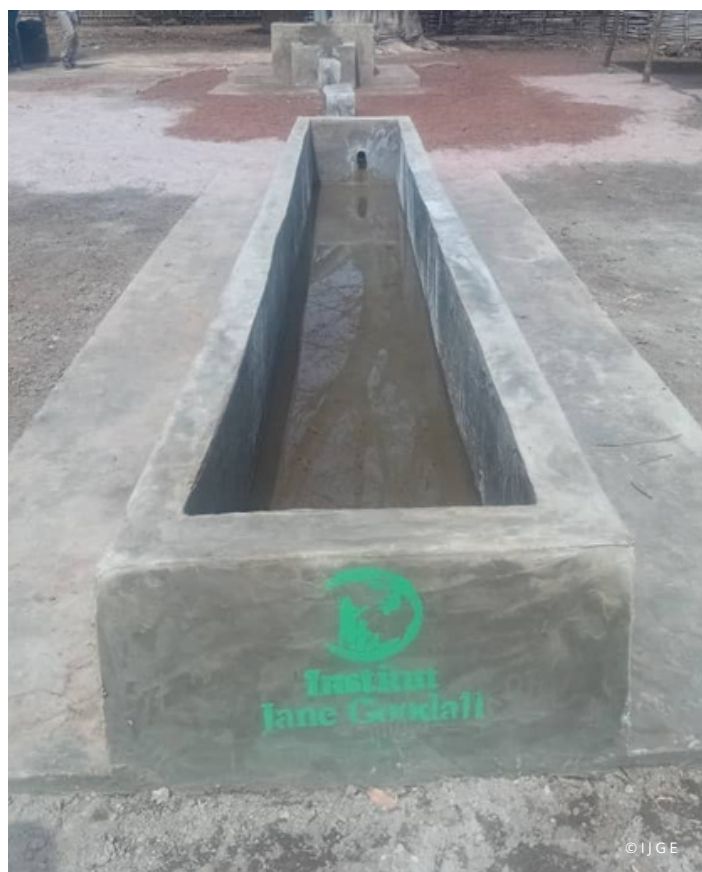
Abrevadero para el ganado construido al lado del pozo
