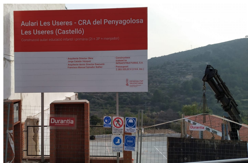
Comencen les obres del nou aulari
