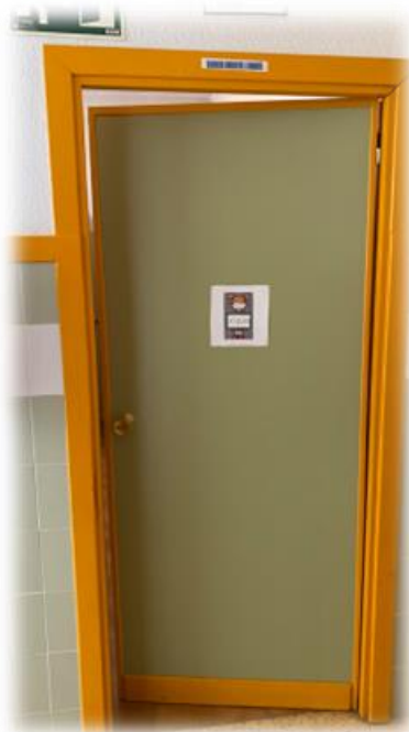
Il·lustració 6. Porta interior zona Antigua.
