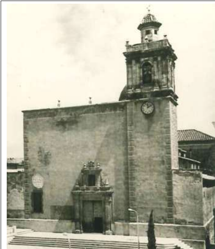
Imatge de l'església parroquial de Sant Bartomeu on es veu la situació del nou rellotge adossat al campanar.
