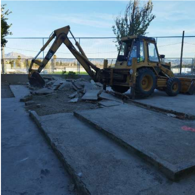
Martín con su retroexcavadora arrancando el suelo de hormigón.
