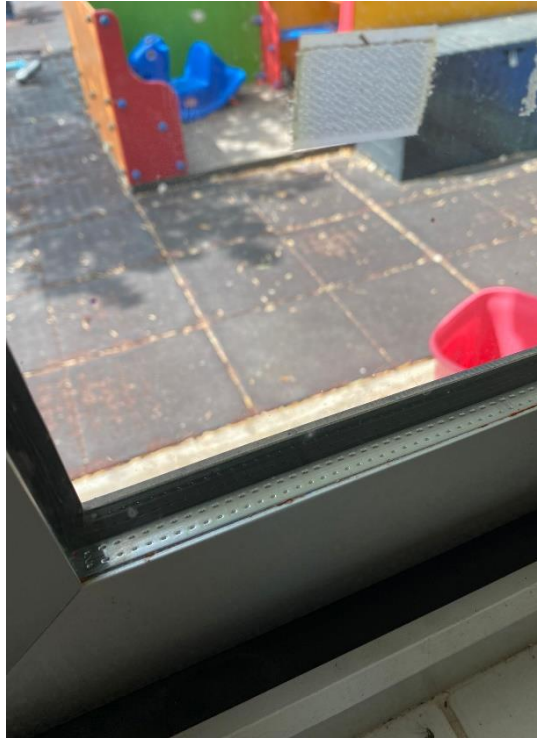
Ilustración 2. Ventanas del colegio, detalle del doble cristal climalit.
