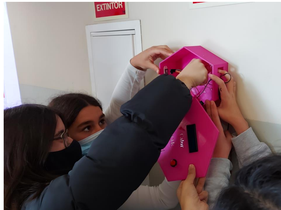
Instal·lació als passadissos del centre
