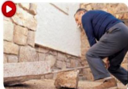
Una barra rígida, colocada debajo de una piedra y con un apoyo, ayudaba a moverla. Esta máquina se llama **palanca**.
