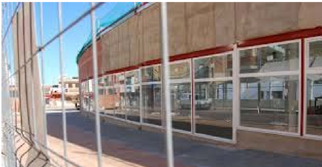
El mercat, en construcció.
