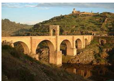
Ponte de Alcántara (Cáceres), que cruza el Tajo, con seis arcos de granito. En el centro tiene un arco del triunfo.
