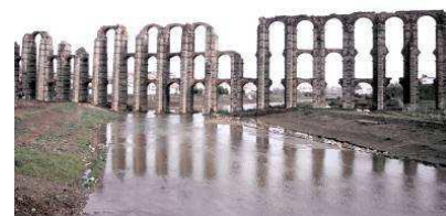
Acueducto de los Milagros , de granito y ladrillo para llevar agua al lado oeste de Emerita Augusta.
