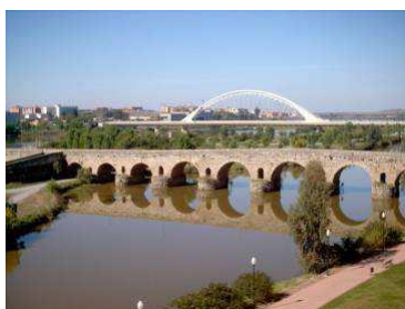
Ponte romano de Mérida , construido en sillaría granítica.
