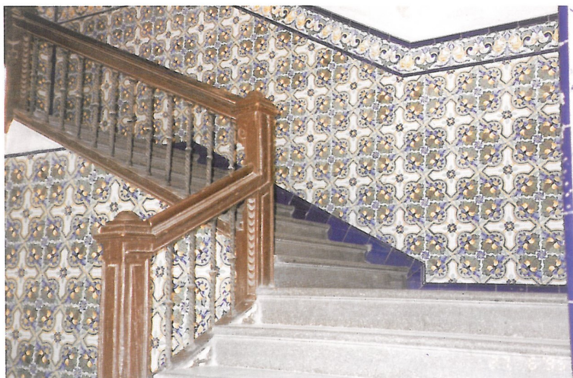
Contrahuella del primer plano de escalera.
