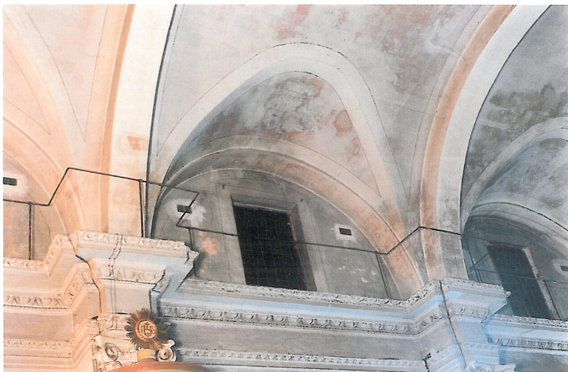
Detalle de los lunetos del lateral derecho, donde se pueden apreciar el sistema de ventilación de muros y las pinturas murales.
