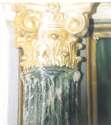
Columna, restauración de grietas y consolidación.
