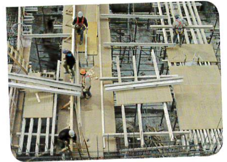
1 Construcció d'un edifici amb bigues de formigó.
