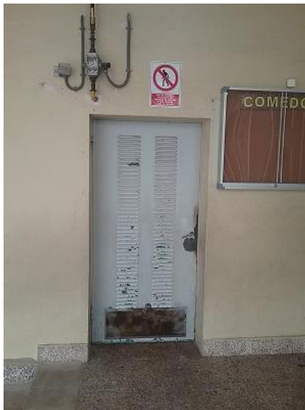
sala de caldera y llave de corte del gas
